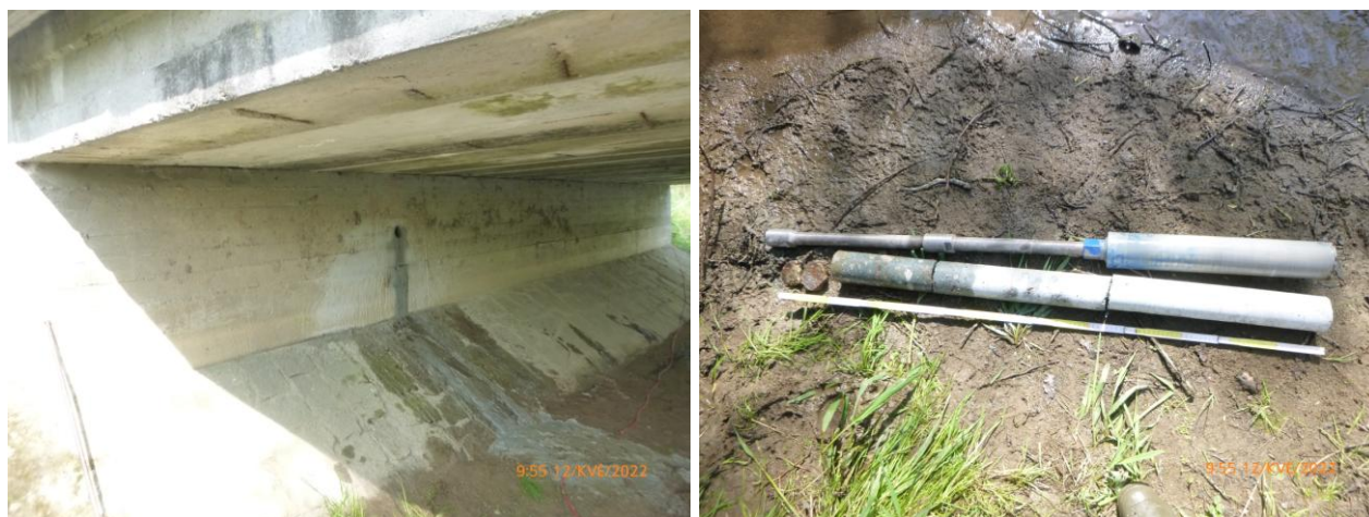
Foto 3.2: Dokumentace vývrtu ke zjištění tloušťky opěry - sonda SK3
